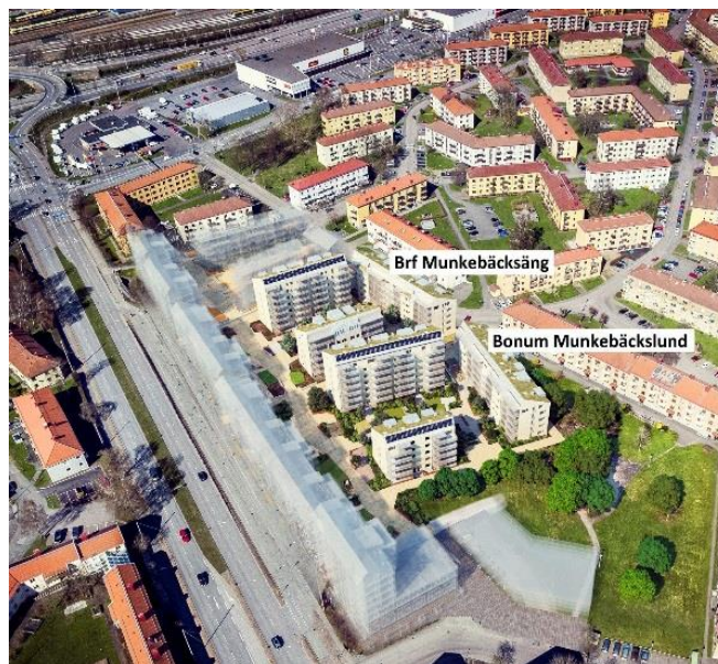
Riksbyggens och Bonums hus, Munkebäcksäng och Munkebäckslund. Tornets del, Munkebäck Hage, är skuggat.
